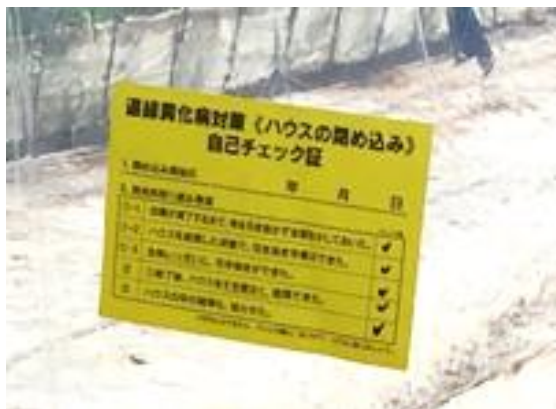
対策ステッカー貼付の様子
