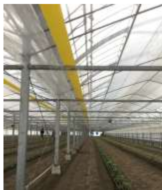
粘着トラップの設置
